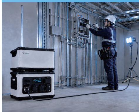
工事現場の電源確保
